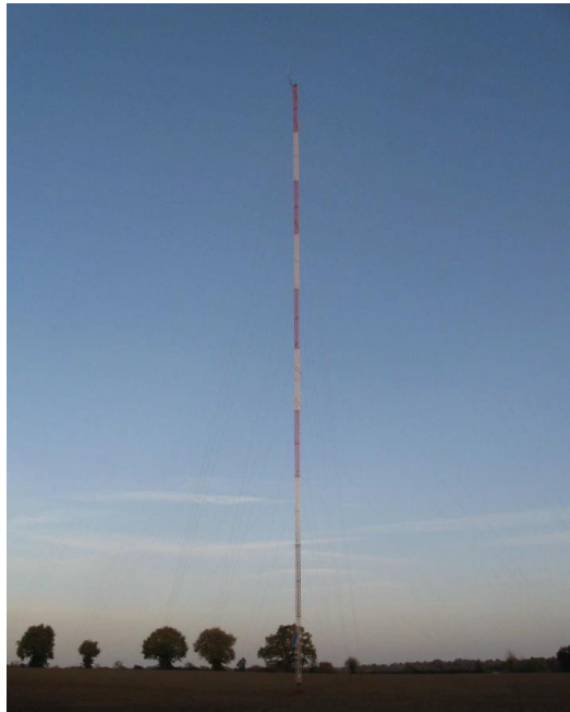
photo 1 : mât de 80 mètres de Site-type
